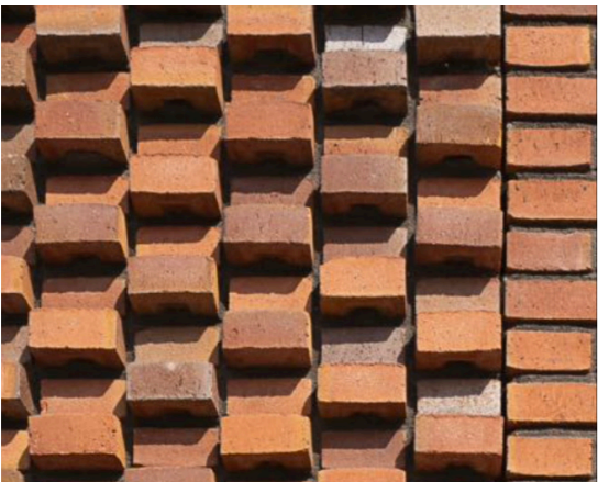
Gevel - metselwerk met reliëf
